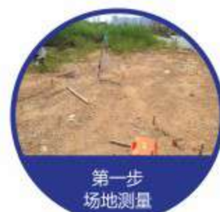
第一步 场地测量 Step 1 Site Measurement
